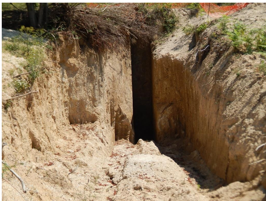
Figura 6 – Ascavação em saibro na área do projecto (captação de água)
